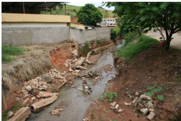
Foto 1 Interceptor existente, em tubo de PVC envelopado, destruído com lançando no córrego.
