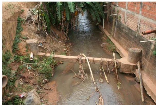
Foto 2 – Interceptor envelopado em tubos de PVC, detalhe da travessia, causando barramento da água de chuva..
