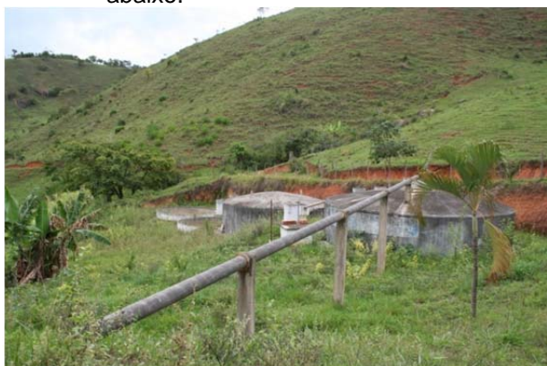
Foto 5 – ETE pré-fabricada em Ferrocimento, a ser abandonada.
